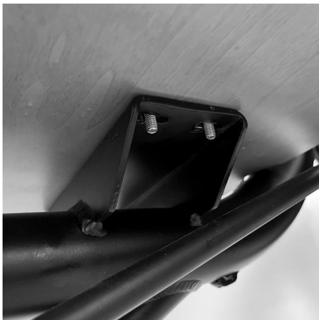
Obrázek 23 - Šroubové spoje cargo boxu - spodní strana
